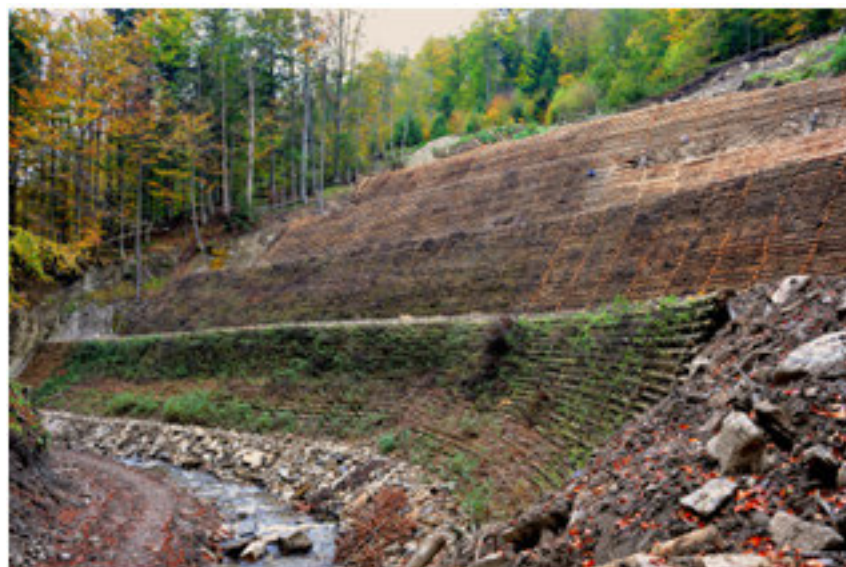
Kaszycę z pędami wierzby zabezpieczającą osuwisko pod drogą podcinaną przez ciek – pędy rozpoczęły wegetację jeszcze przed zakończeniem budowy. Nadleśnictwo Stuposiany. Źródło: Archiwum CKPS.
