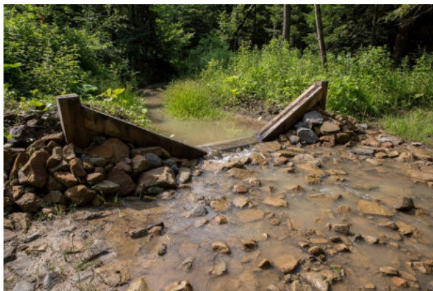
Próg powyżej brodu ukierunkowujący wodę na bród.
