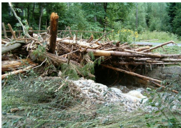
Rumosz niesiony wodą w czasie katastrofalnego wezbrania osadzony na moście. Źródło: Archiwum CKPŚ. Zerwany most w Nadleśnictwie Łądek Zdrój. Źródło: Archiwum CKPŚ.
